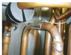
Remove the Thermistor(Discharge).
